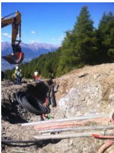
Прокладка чугунных труб
