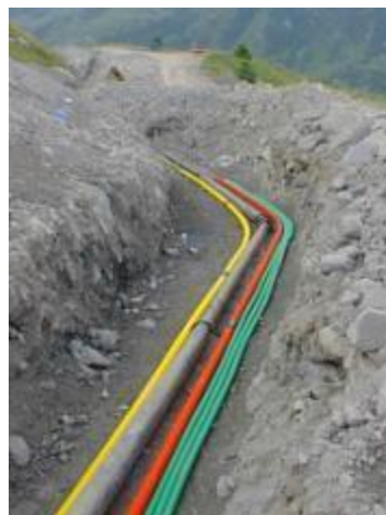
Прокладка кабеля в траншее с полиэтиленовой изоляцией
