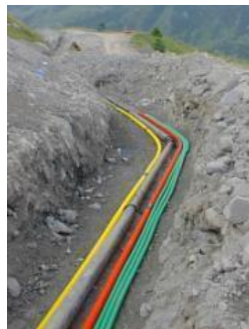
Прокладка кабеля в траншее с полиэтиленовой изоляцией
