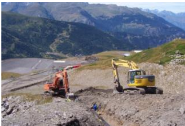
Прокладка стальных труб
