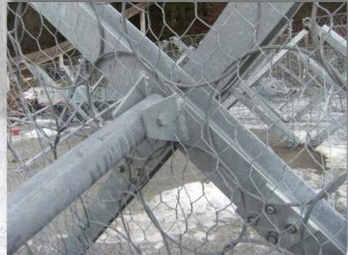
Fig. 3: Connessione a cerniera
